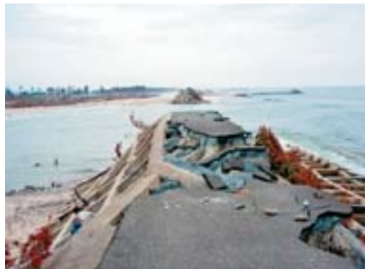
宮城県山元町の護岸堤防の上。高さ6メートル以上はある堤防がえぐりとられている。
